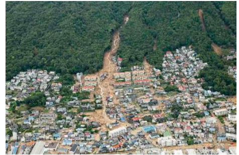
写真 2 5 土砂災害写真
